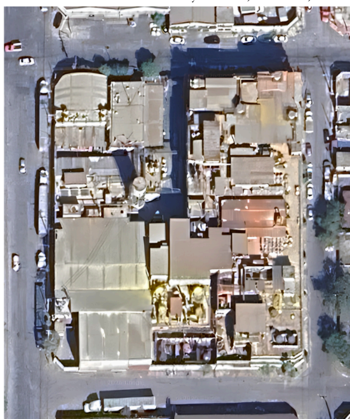
Figura 11. Instalación ubicada en Manuel de la Peña y Peña 930, Bella Vista, 64410 Monterrey, N.L.
