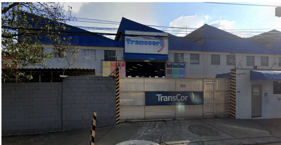
Figura 7. Instalación de TransCor ubicada en Rua Sitha, 375 – Núcleo Habitacional União, Diadema – SP.
