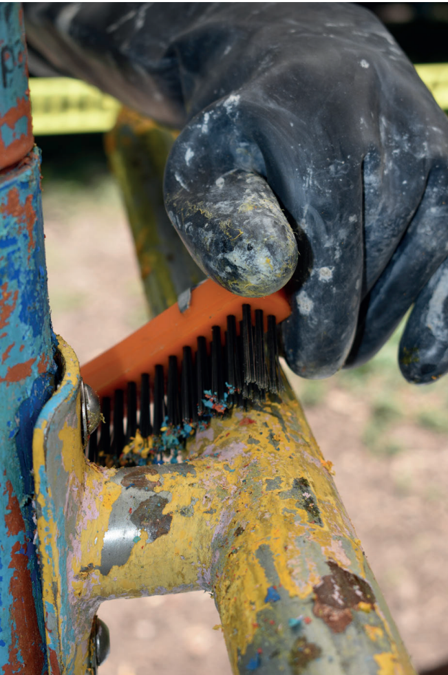
Figura 13. Remoción de la pintura con removedor y cepillo de alambre.
