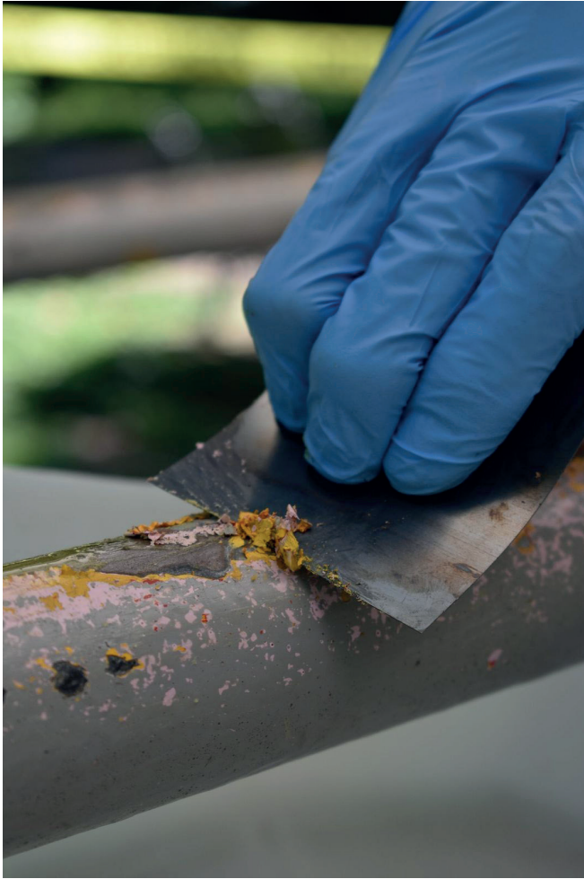
Figura 12. Remoción de la pintura con removedor y espátula.
