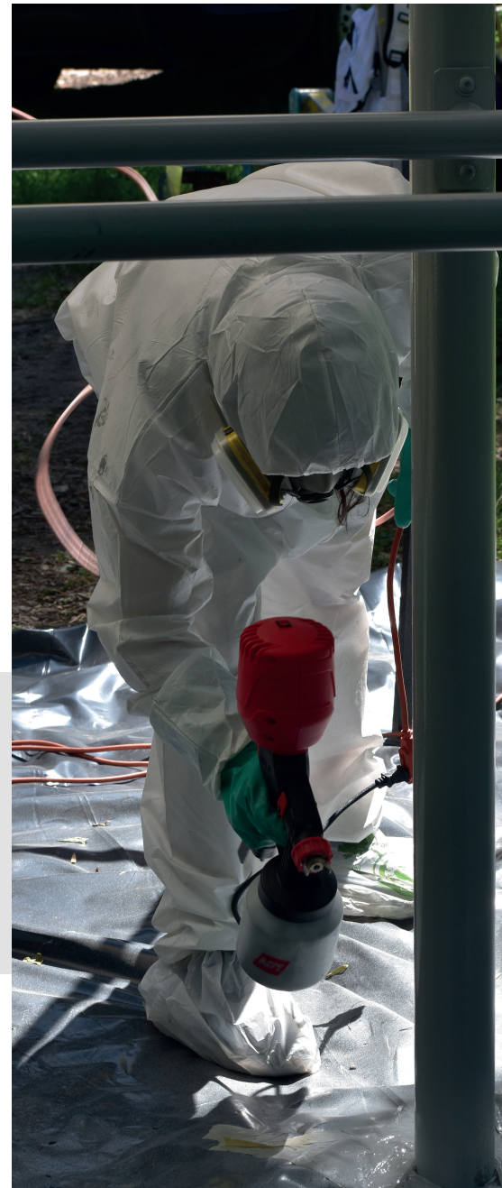
Figura 18. Aplicación de pintura de esmalte base agua con pistola de aire.
